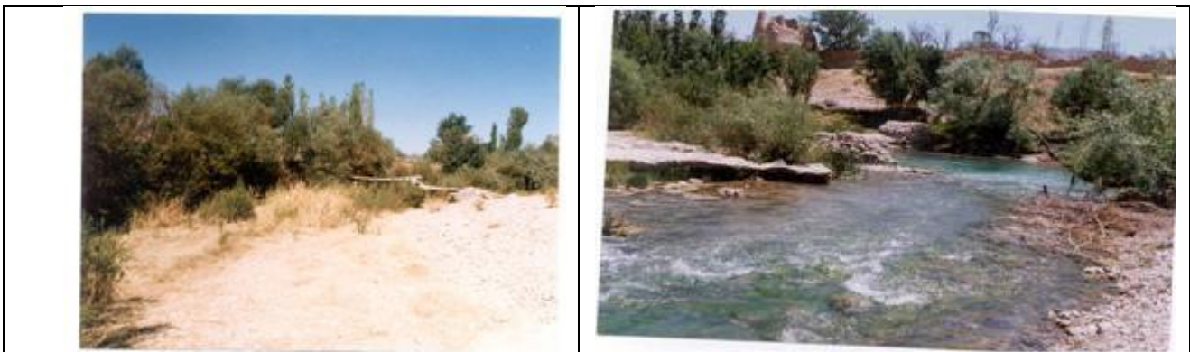
شکل ۵- نمونه ای از پل های قدیمی تخریب شده در رودخانه قره چای
