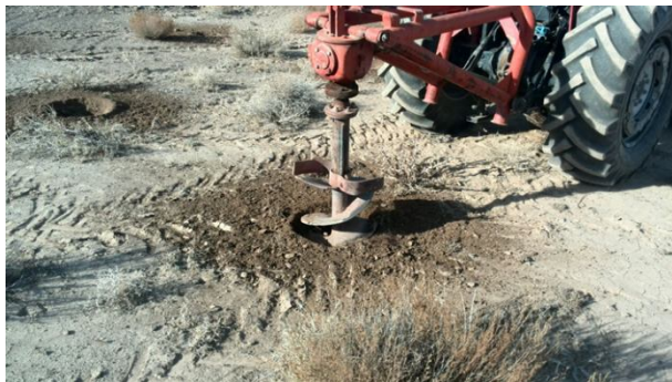
شکل ۲- استفاده از تراکتور مجهز به مته چاله کنی جهت حفر گمانه در مخزن بند
