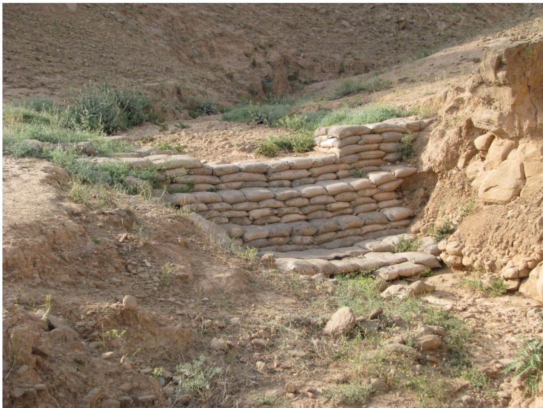
شکل ۵- نمایی از یک نمونه بند خشکه چین ساخته شده با استفاده از مخلوط خاک-سیمان در منطقه بالادست سد کرخه
