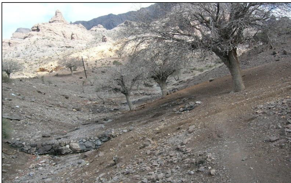
شکل ۲- احداث خشکه چین به منظور تثبیت حوزه آبخیز و افزایش سطح زیر کشت در شاخه های ابتدایی با مشارکت مردمی
