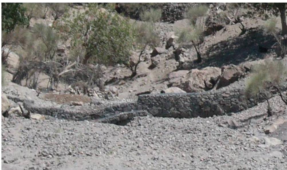
شکل ۳- بند گابیون احداثی به منظور تثبیت حوزه آبخیز و افزایش سطح زیر کشت در بالا دست با مشارکت مردمی
