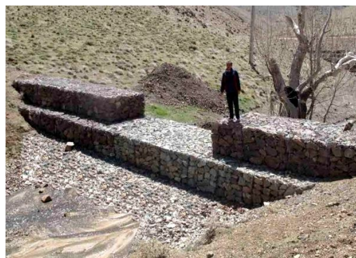
شکل ۱۵- بند گابیونی با سرریز پلکانی نوع G1
