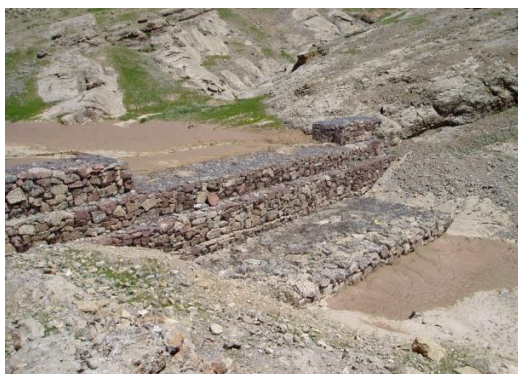
شکل ۱۶- بند گابیونی با سرریز پلکانی نوع G2
