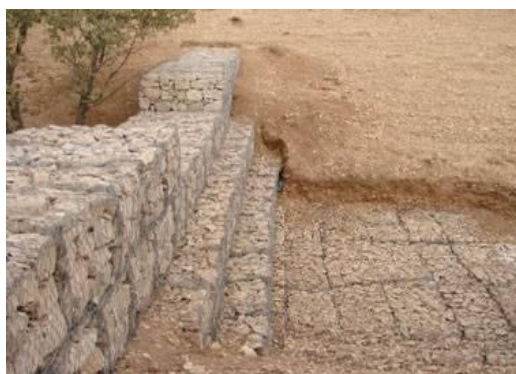
شکل ۱۷- بند گابیونی با سرریز پلکانی نوع G3
