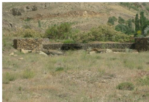
شکل ۳- نمایی از گابیون در ابراهه اصلی
