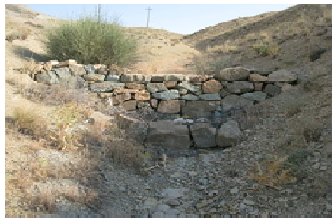
شکل ۲- نمایی از خشکه چین در حوضه هفتان
